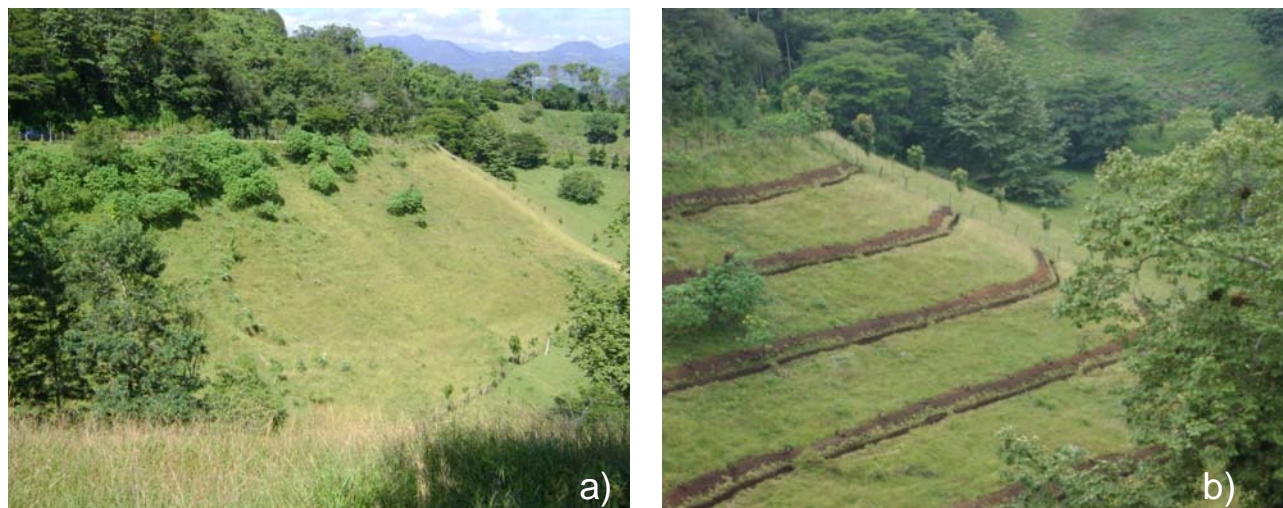
FIGURA 1. Vista del sitio experimental en el Centro Regional Universitario Oriente, UACH, Huatusco, Veracruz. a) – Julio, 2008); y b) Septiembre, 2008, con bordos a nivel. Fotos: Quinto. L.
