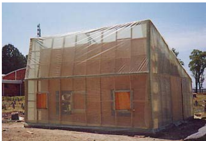
Figura 3. Secador solar terminado y en funcionamiento.
