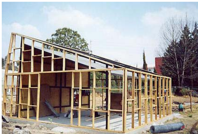
Figura 2. Secador solar en proceso de construcción.
